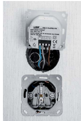
Bild 22: Der fertig verkabelte Aktor ...
