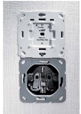
Bild 23: ... wird in die Installationsdose eingesetzt und verschraubt.
