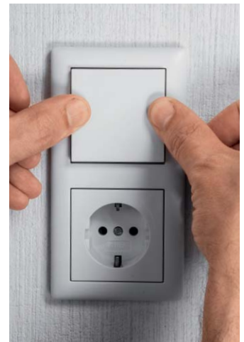
Bild 25: Abschluss der Installation: Einsetzen der Tasterwippe
