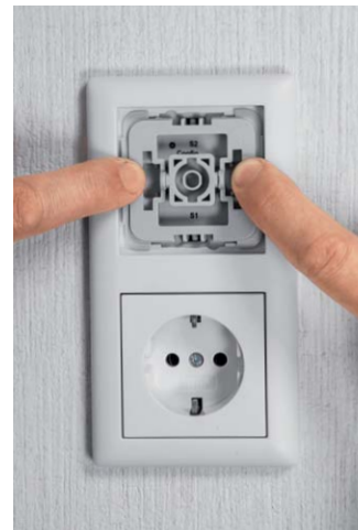
Bild 24: Der Abdeckrahmen des Installationssystems wird aufgesetzt.
